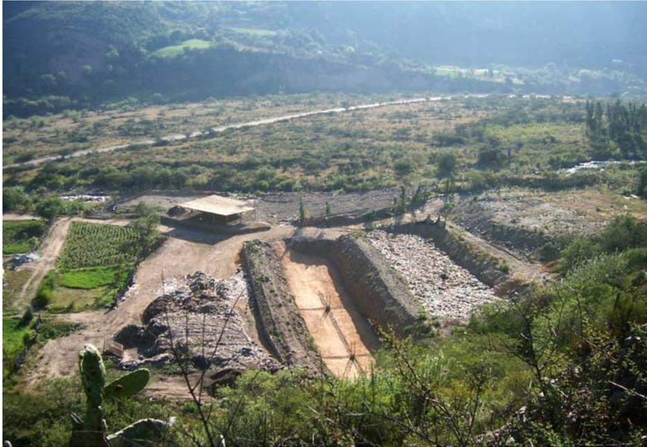
Imagen N° 1 Vista de un relleno sanitario manual.
